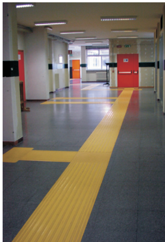
Percorso guida a terra in gomma - Istituto Secco Suardo - Bergamo
