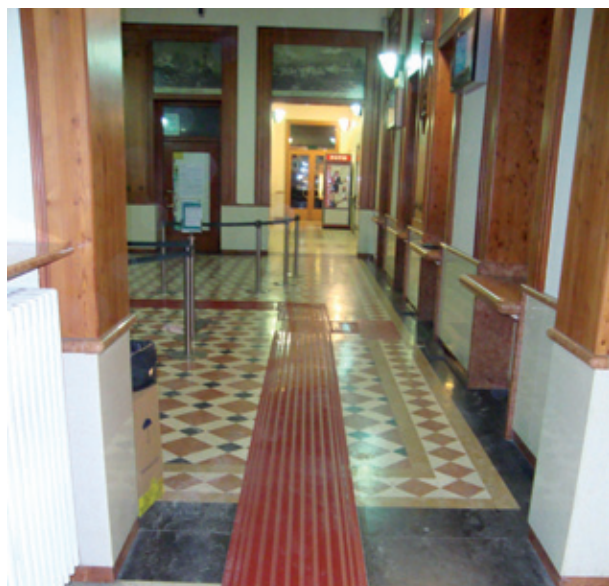
Percorso guida a terra in gomma - Stazione Ferroviaria di Belluno
