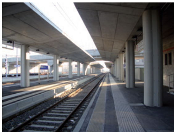
Percorso guida a terra in cls - Stazione Ferroviaria Stura a Torino
