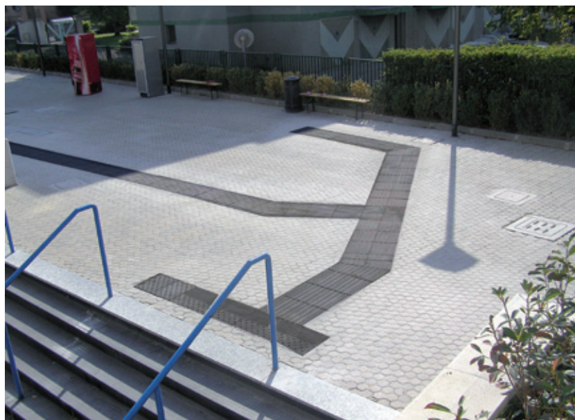
Percorso guida a terra in cls Palasport di Voghera
