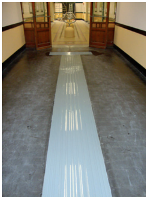
Percorso guida a terra in gomma - Galleria Castelletto a Genova
